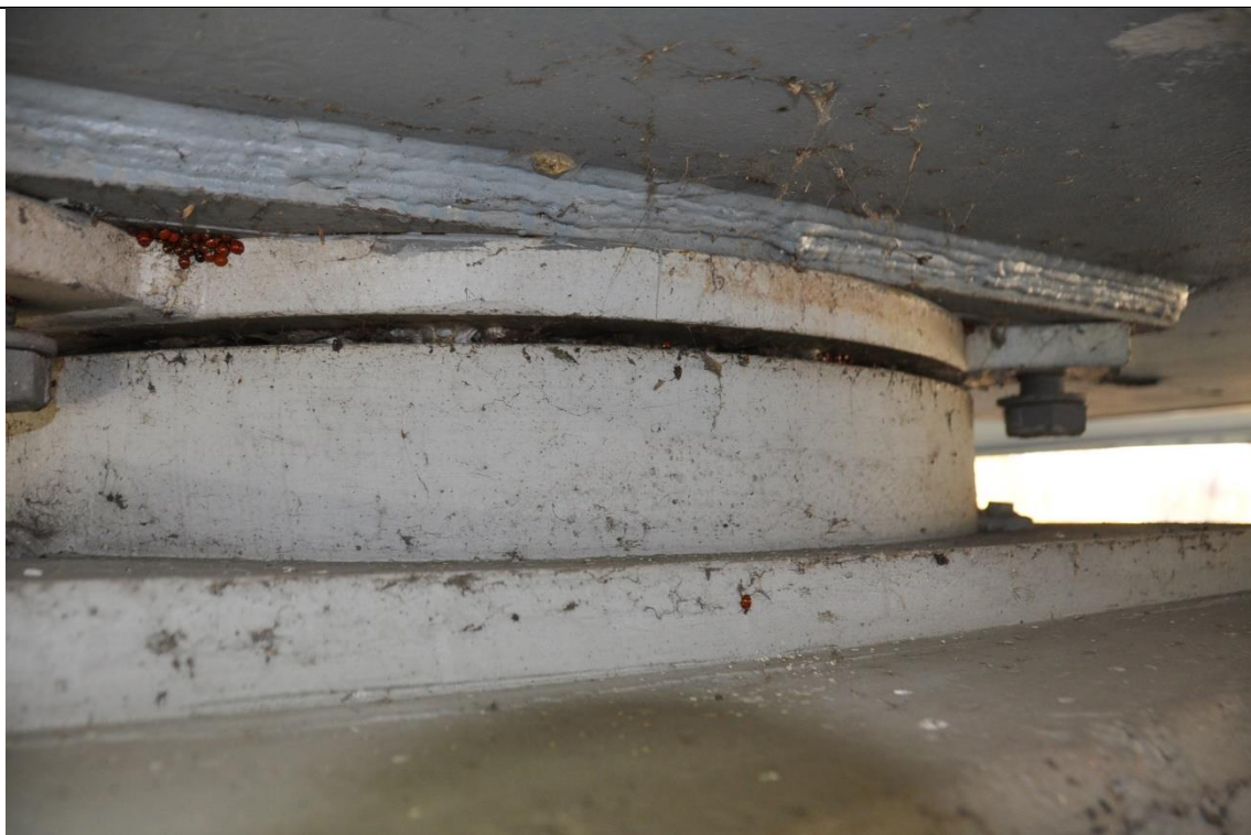
Fot. 23 Widok łożyska LC-6 (jezdnia prawa w kierunku Warszawy)
