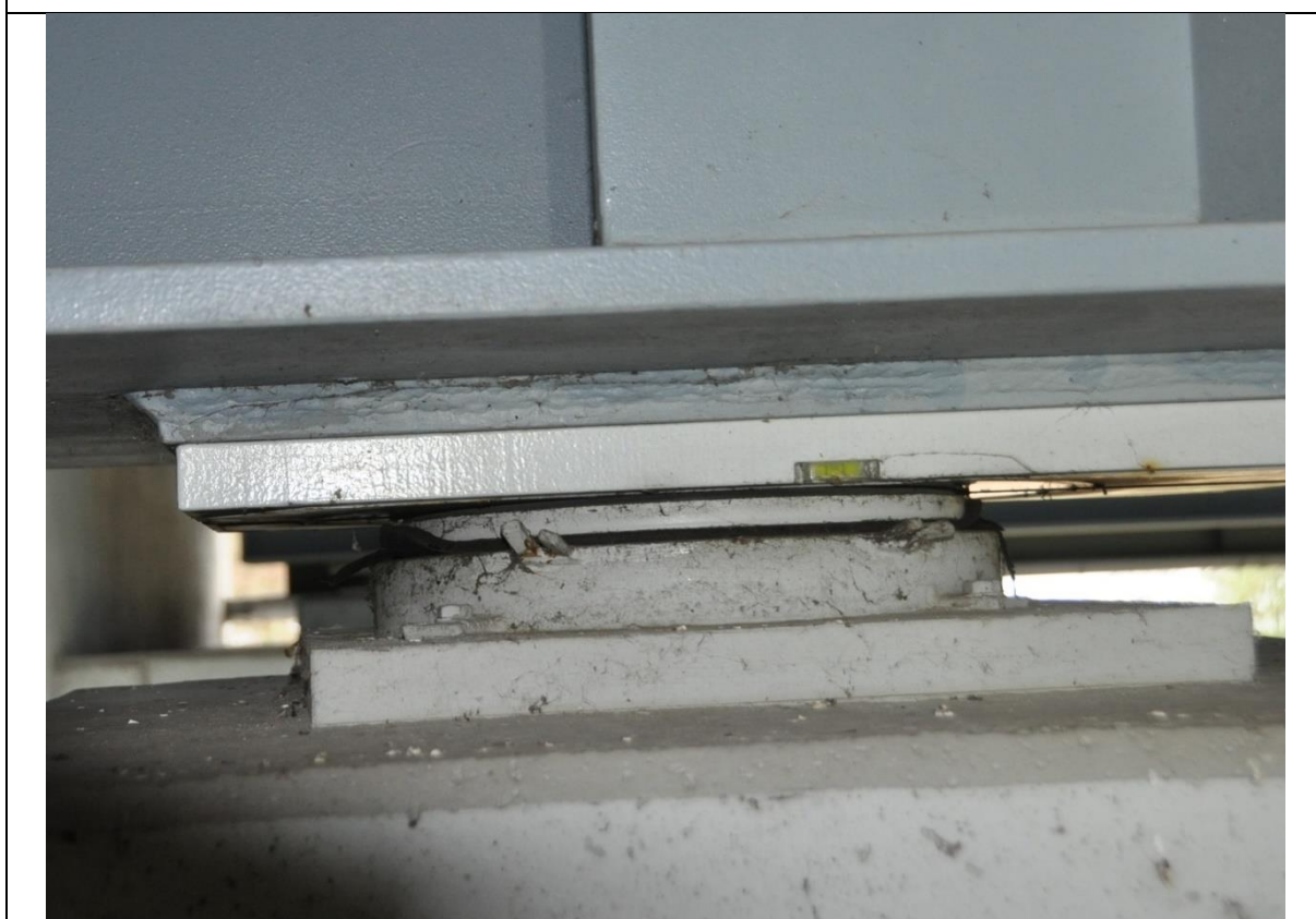
Fot. 46 Widok łożyska LB-12 (jezdni lewa w kierunku Poznania)
