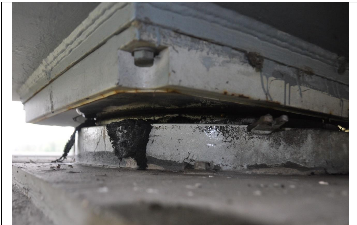
Fot. 9 Widok łożyska LA-3 (jezdnia lewa w kierunku Poznania)
