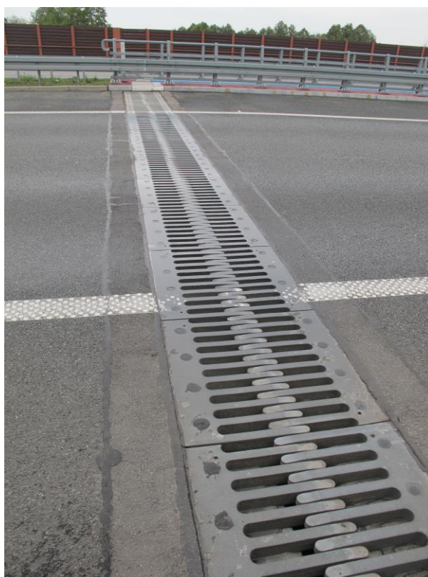
Fot. 1 Widok płaczastego urządzenia dylatacyjnego B2P400 wbudowanego nad podporą skrajną w osi 1 (jezdnią prawą w kierunku Warszawy)
