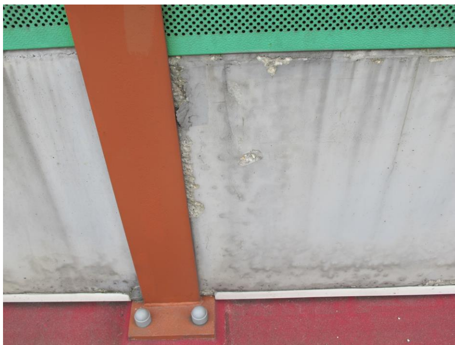
Fot. 12 Uszkodzenia podwaliny betonowej związane z nieprawidłowym jej osadzeniem w stalowych słupach
