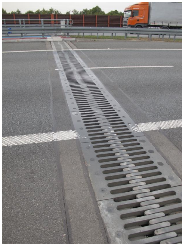
Fot. 2 Widok palczastego urządzenia dylatacyjnego B2P400 wbudowanego nad podporą skrajną w osi 12 (jezdnia prawa w kierunku Warszawy)
