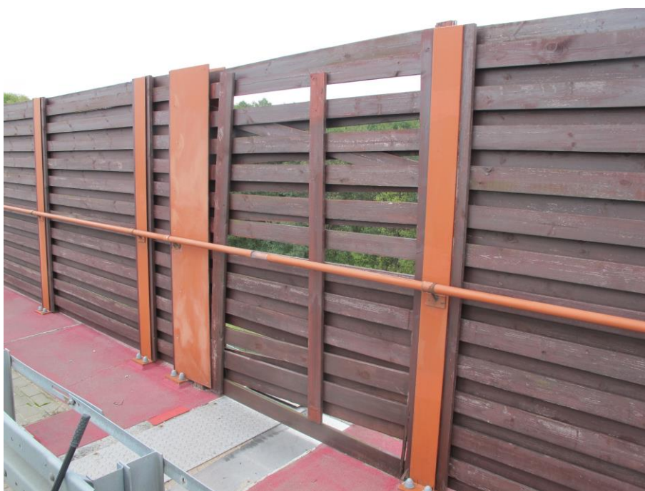
Fot. 14 Uszkodzenia drewnianych ekranów akustycznych w strefie urządzeń dylatacyjnych wbudowanych nad podporą w osi 12 (most S)
