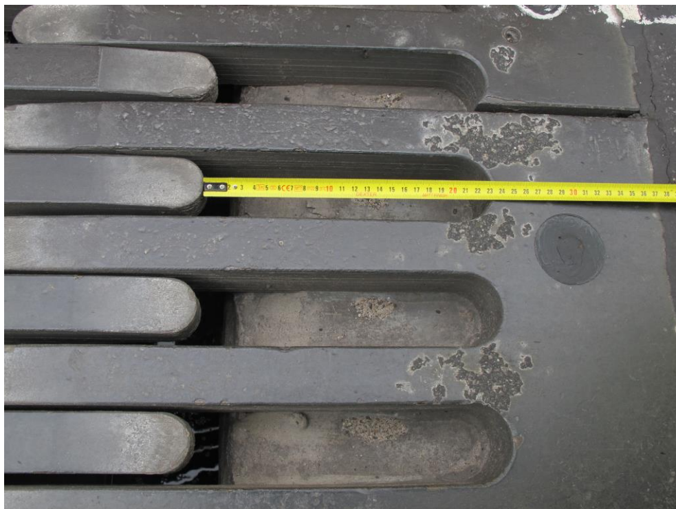
Fot. 5 Przykładowy pomiar szerokości rozwarcia elementów palczastych urządzenia dylatacyjnego B2P400 wbudowanego na moście S nad podporą w osi 1
