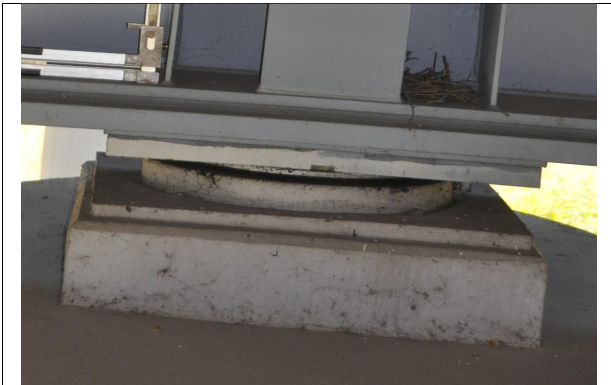
Fot. 7 Widok łożyska LC-2 (jezdnia prawa w kierunku Warszawy)
