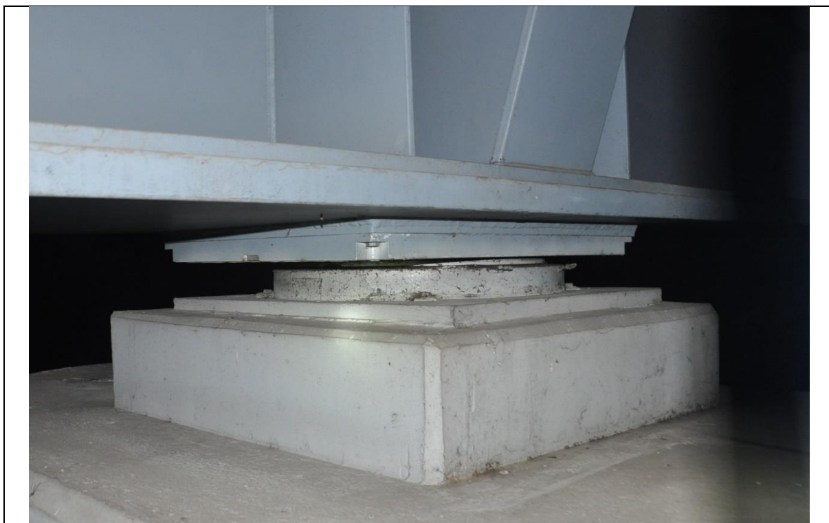
Fot. 37 Widok łożyska LA-10 (jezdnia lewa w kierunku Poznania)
