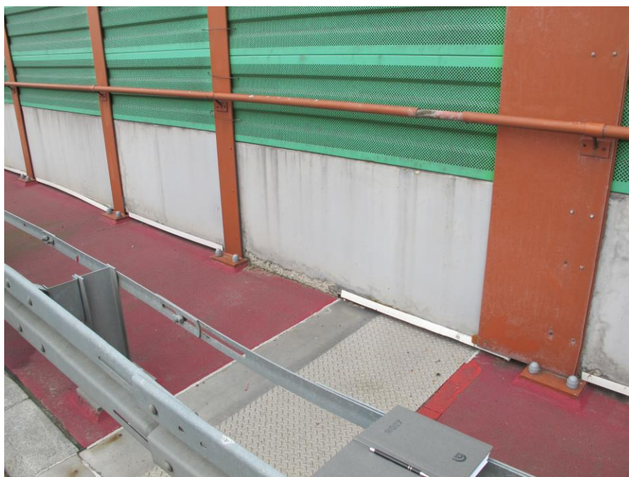
Fot. 11 Ubytki i złuszczenia na powierzchni betonowych podwalin pod ekrany akustyczne
