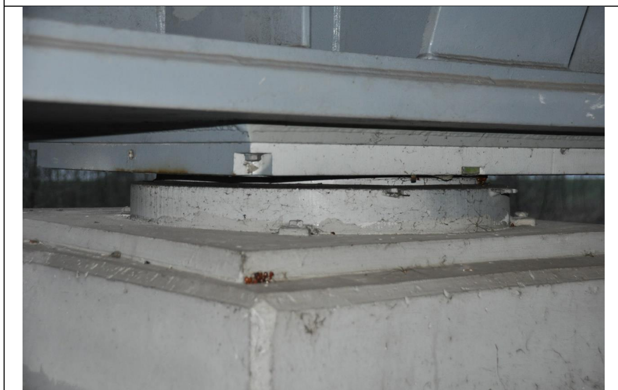
Fot. 40 Widok łożyska LD-10 (jezdnia prawa w kierunku Warszawy)
