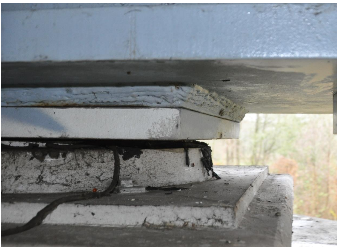
Fot. 1 Typowe uszkodzenie łożyska wyciskany elastomer
