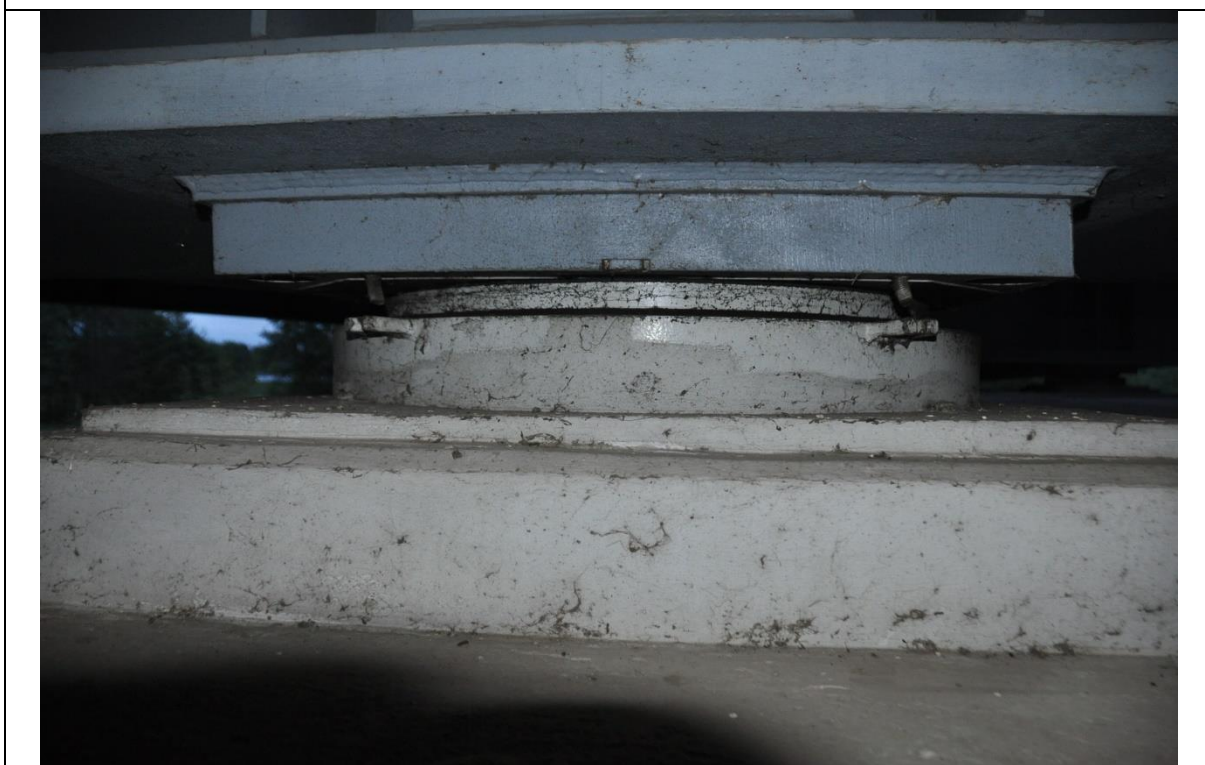
Fot. 18 Widok łożyska LB-5 (jezdnia lewa w kierunku Poznania)
