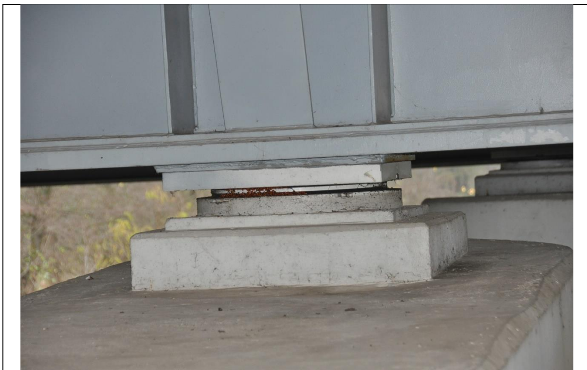
Fot. 31 Widok łożyska LC-8 (jezdnia prawa w kierunku Warszawy)
