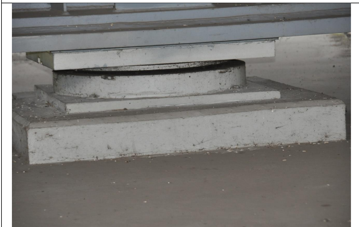
Fot. 14 Widok łożyska LB-4 (jezdnia lewa w kierunku Poznania)
