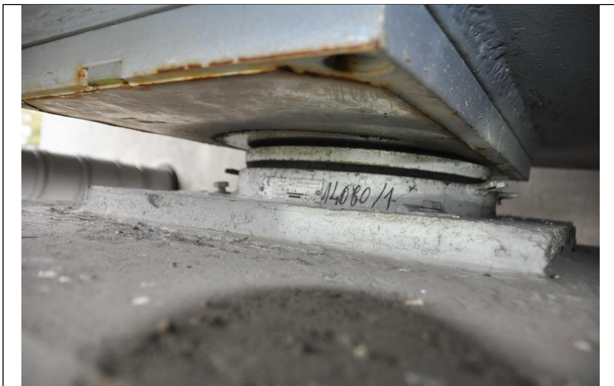
Fot. 45 Widok łożyska LA-12 (jezdni lewa w kierunku Poznania)
