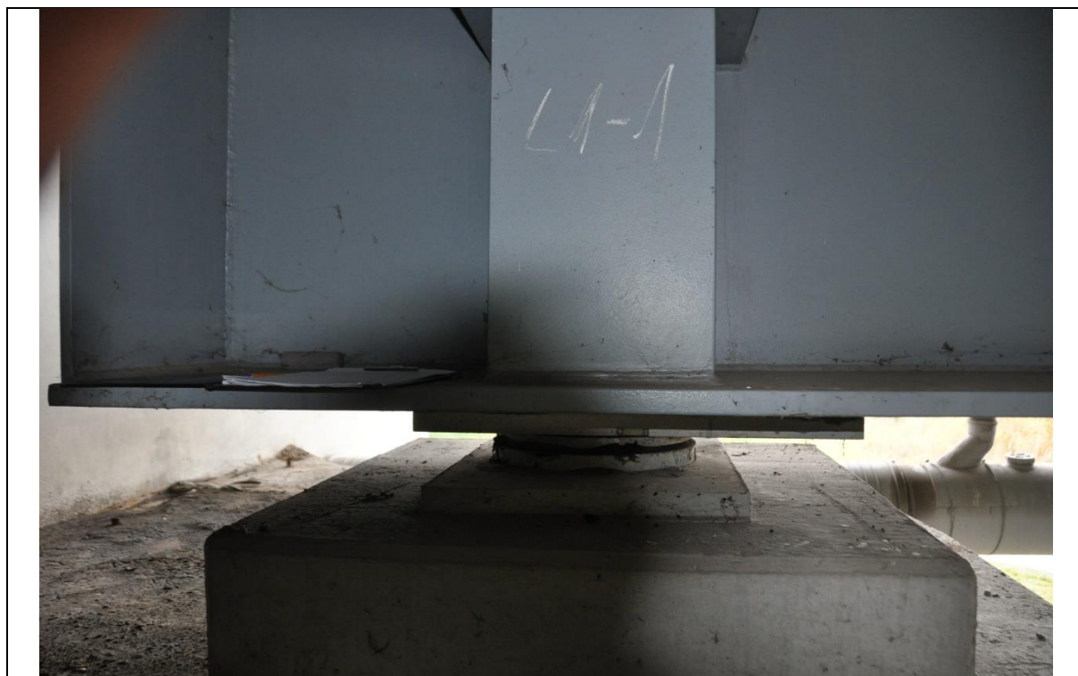
Fot. 1 Widok łożyska LA-1 (jezdnia lewa w kierunku Poznania)
