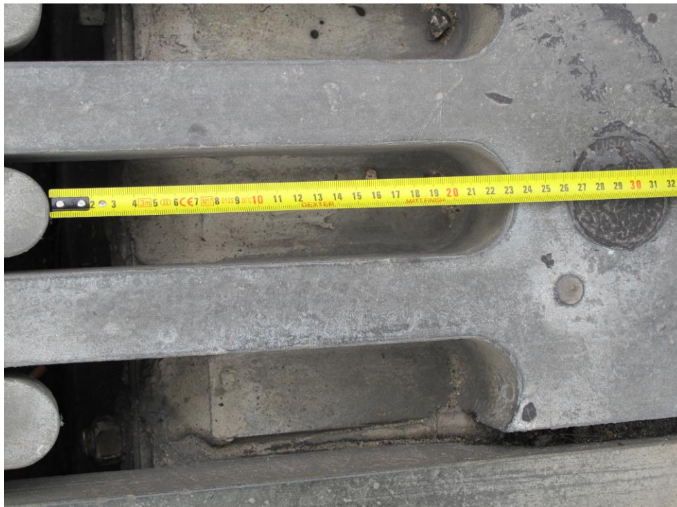
Fot. 8 Pomiar szerokości rozwarcia elementów palczastych urządzenia dylatacyjnego B2P400 wbudowanego na mości N nad podporą w osi 12
