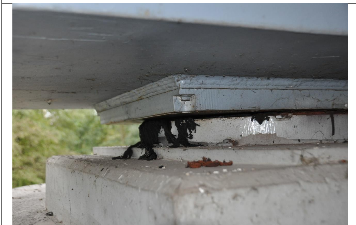
Fot. 16 Widok łożyska LD-4 (jezdnia prawa w kierunku Warszawy)
