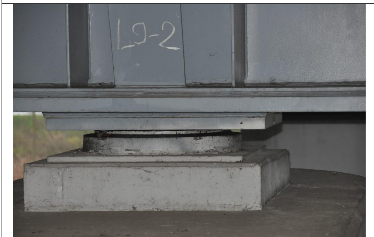
Fot. 34 Widok łożyska LB-9 (jezdnia lewa w kierunku Poznania)
