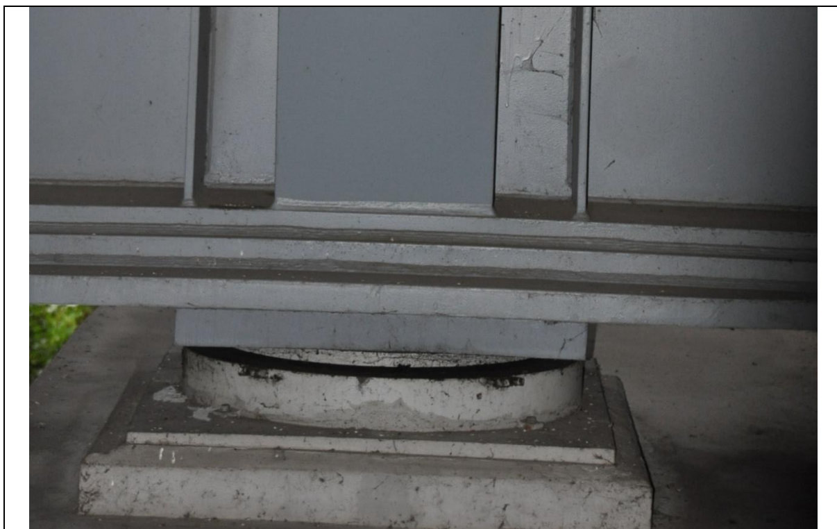
Fot. 19 Widok łożyska LC-5 (jezdnia prawa w kierunku Warszawy)
