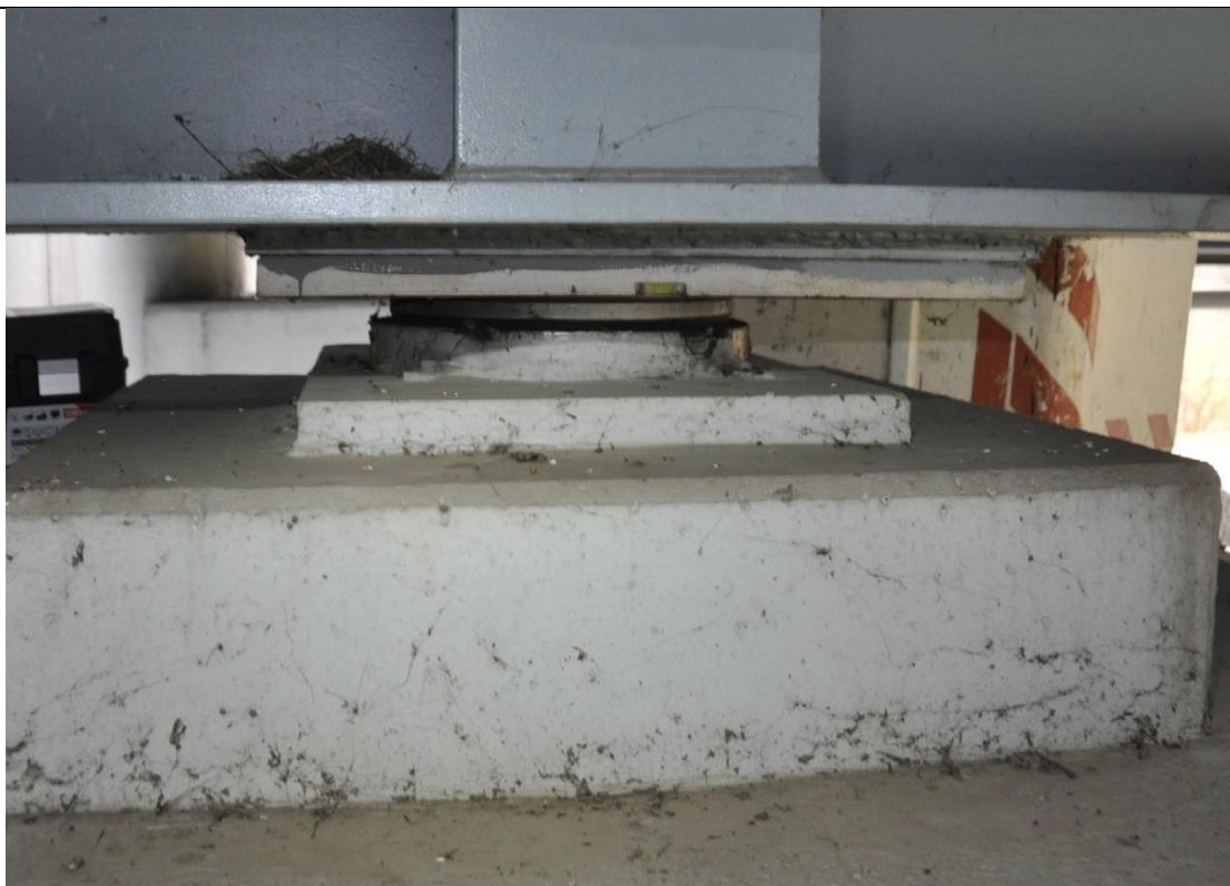
Fot. 3 Widok łożyska LC-1 (jezdnia prawa w kierunku Warszawy)
