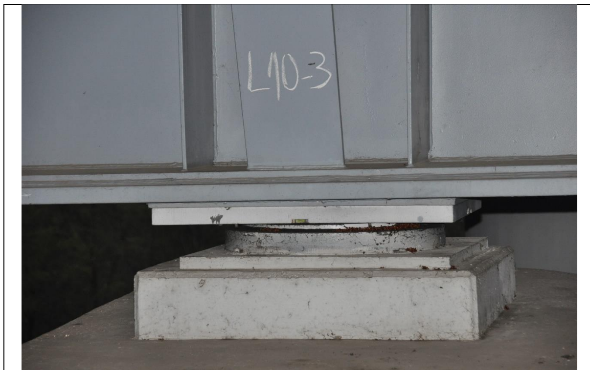
Fot. 39 Widok łożyska LC-10 (jezdnia prawa w kierunku Warszawy)
