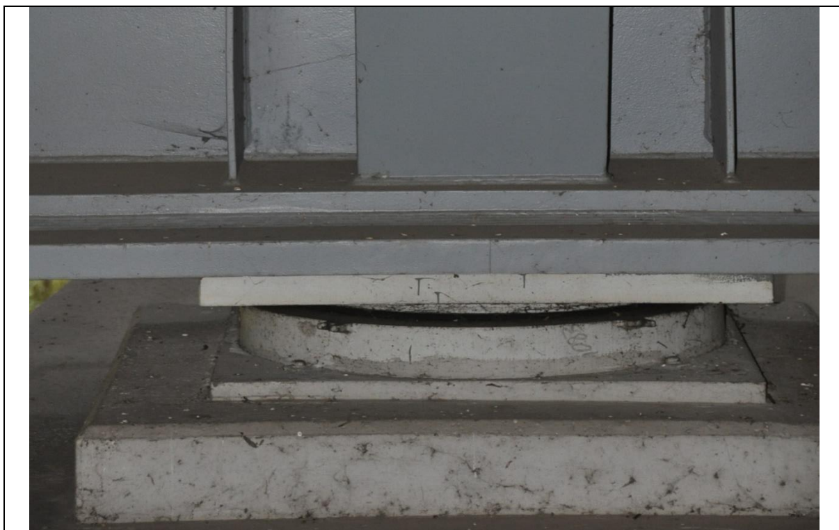
Fot. 15 Widok łożyska LC-4 (jezdnia prawa w kierunku Warszawy)
