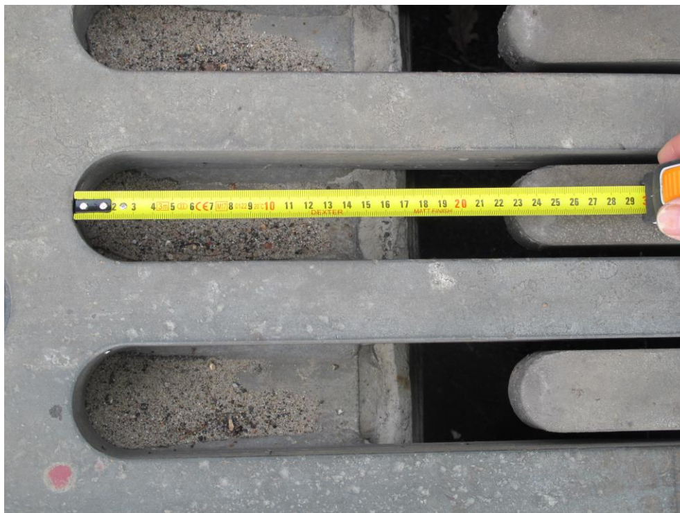
Fot. 7 Przykładowy pomiar szerokości rozwarcia elementów palczastych urządzenia dylatacyjnego B2P400 wbudowanego na mości N nad podporą w osi 1
