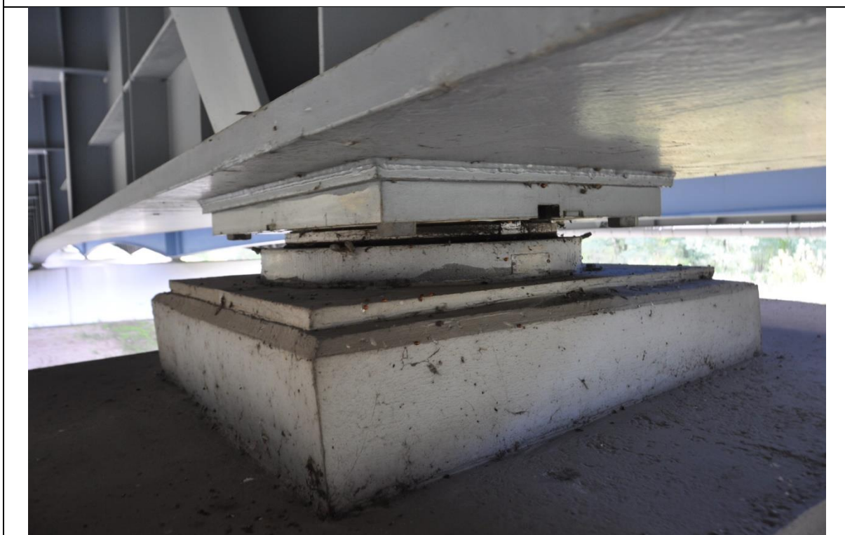
Fot. 10 Widok łożyska LB-3 (jezdnia lewa w kierunku Poznania)
