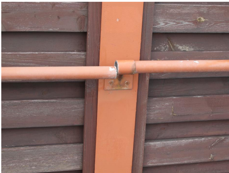
Fot. 13 Korozja elementów stalowych mocujących pochwyty, w tym pochwyty, do stalowych słupów a także uszkodzenie pochwyty (most N, około 23 m od osi 1 w kierunku osi 12). Zabezpieczenie elementów drewnianych wymaga odnowienia
