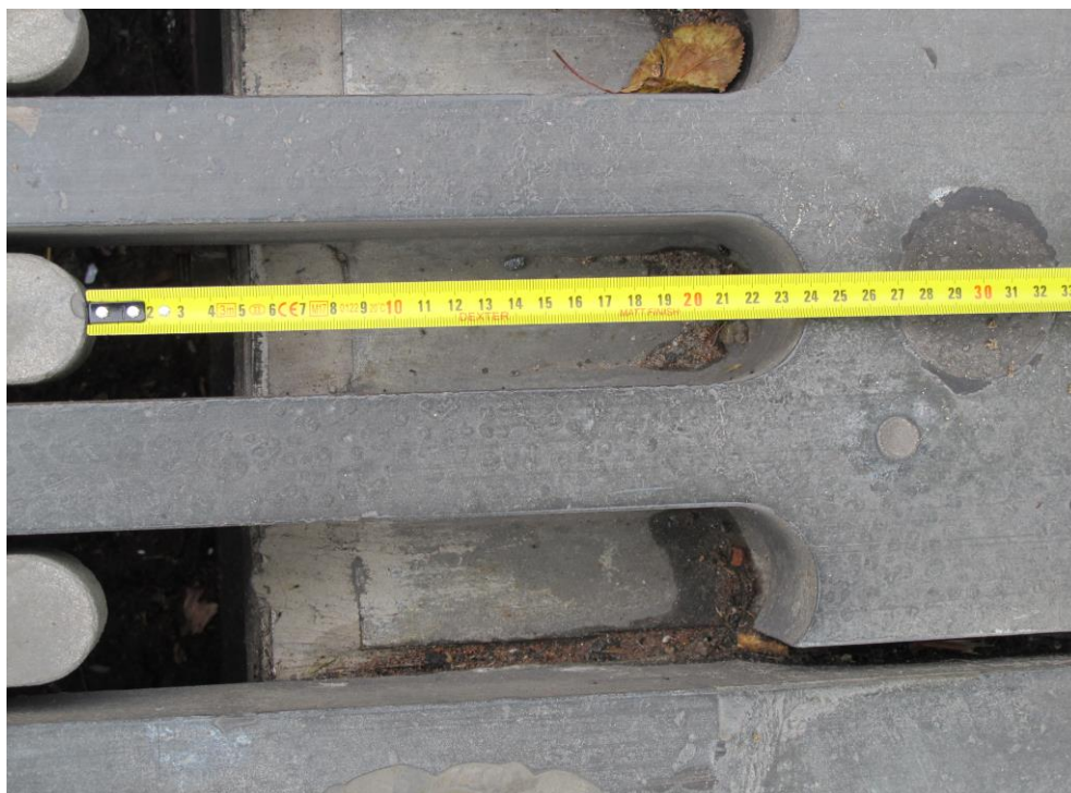
Fot. 6 Przykładowy pomiar szerokości rozwarcia elementów palczastych urządzenia dylatacyjnego B2P400 wbudowanego na moście S nad podporą w osi 12
