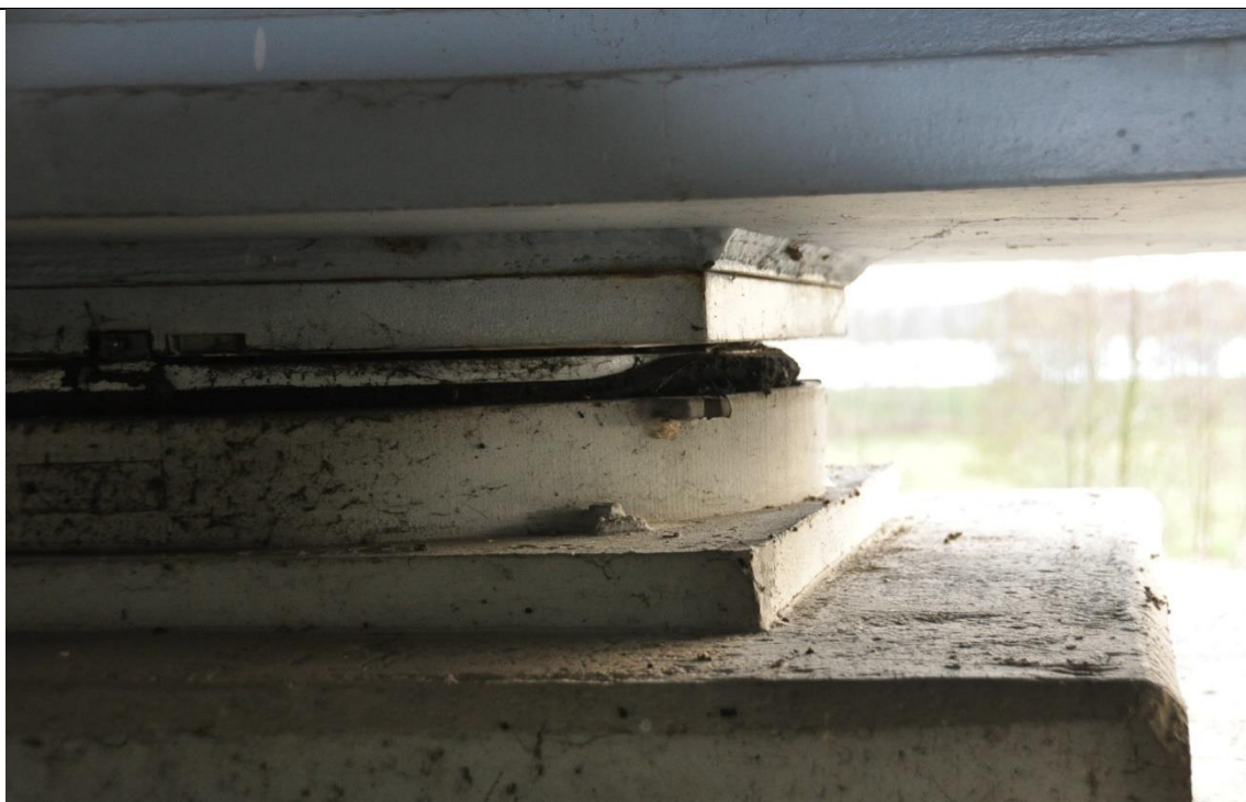
Fot. 24 Widok łożyska LD-6 (jezdnia prawa w kierunku Warszawy)
