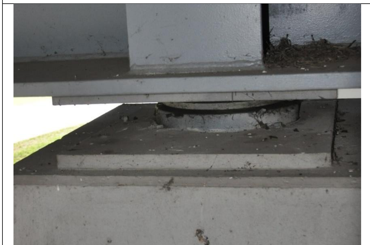
Fot. 2 Widok łożyska LB-1 (jezdnia lewa w kierunku Poznania)
