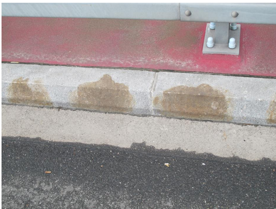
Fot. 15 Rdzawe wykwity na licu krawężników granitowych
