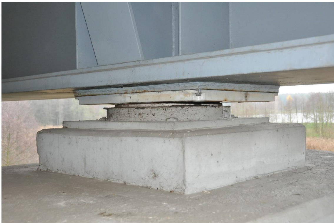
Fot. 36 Widok łożyska LD-9 (jezdnia prawa w kierunku Warszawy)
