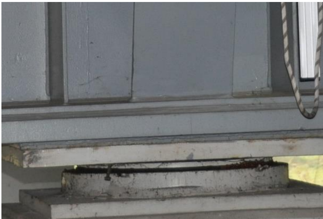
Fot. 35 Widok łożyska LC-9 (jezdnia prawa w kierunku Warszawy)
