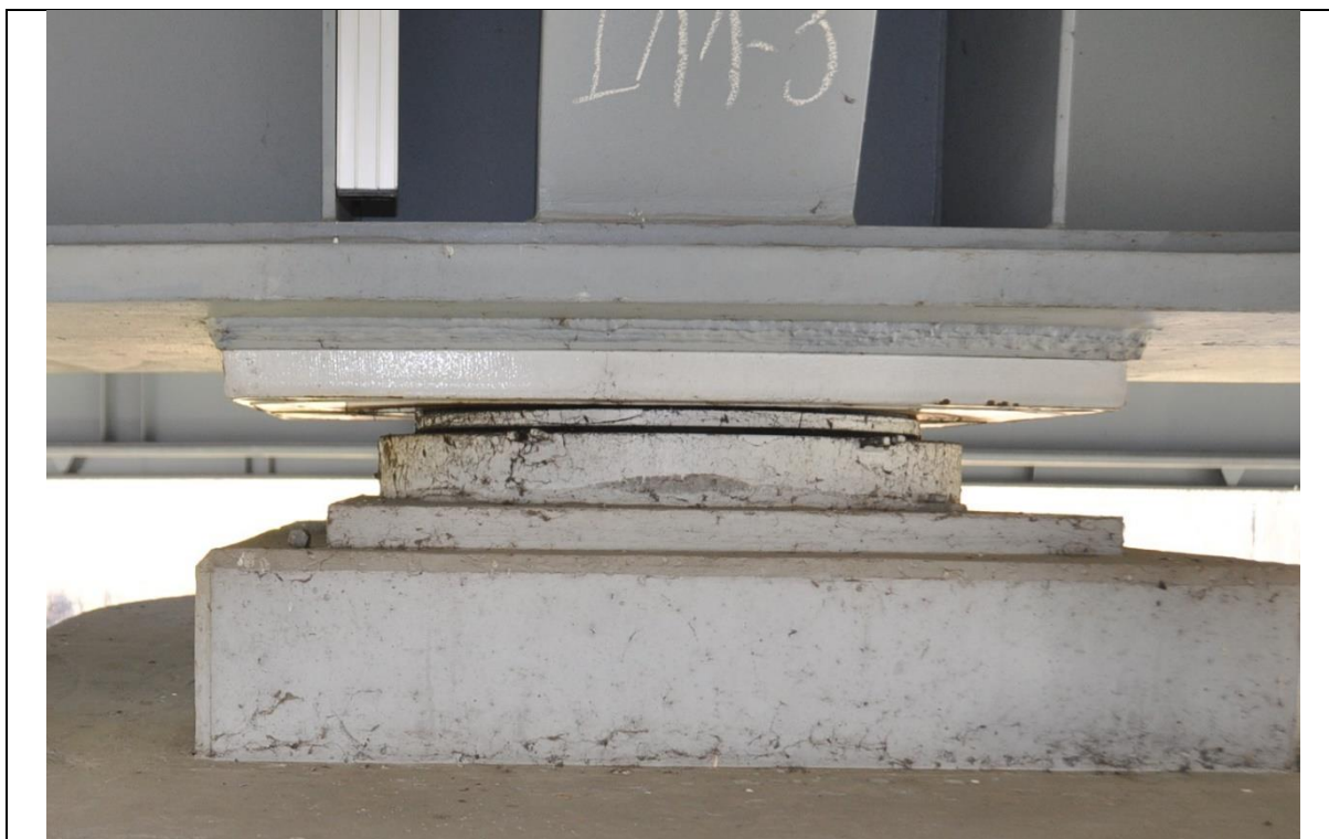
Fot. 43 Widok łożyska LC-11 (jezdnia prawa w kierunku Warszawy)
