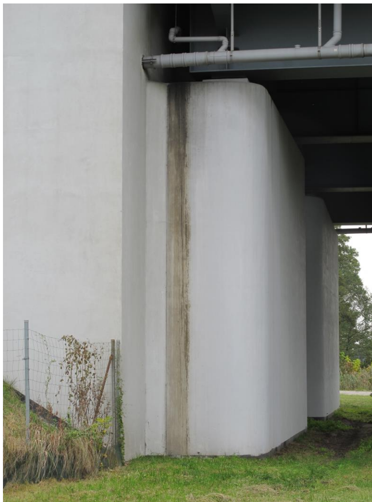
Fot. 19 Zaciek na ścianie bocznej przyczółka w osi 12 od strony północnej
