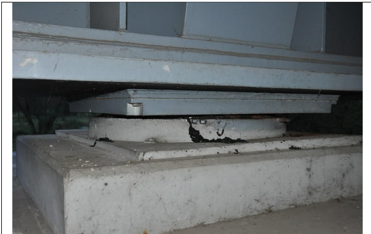
Fot. 17 Widok łożyska LA-5 (jezdnia lewa w kierunku Poznania)
